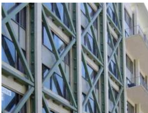
Fig. 32. Esempio di intervento strutturale per rinforzare gli edifici sottoposti a sollecitazioni sismiche.
